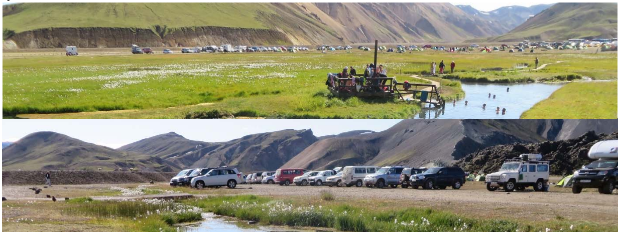
Mynd 46. Varnargarðar við Jökulgilskvísl, sést hæð þeirra í landslaginu en draga þarf úr halla sem snýr að svæðinu inn í Laugum.
